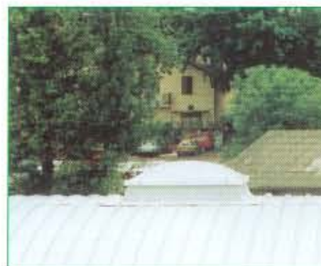
Lichtkuppeln auf Profilblechdach Coupoles sur toit en tôle
